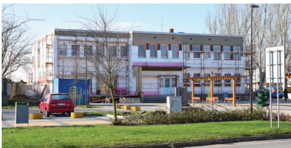
A Szolgáltatások házána hősígetelése
